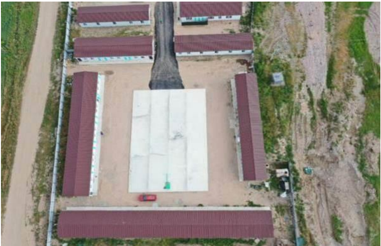
Figure 21: Camp site (km 148+630).
