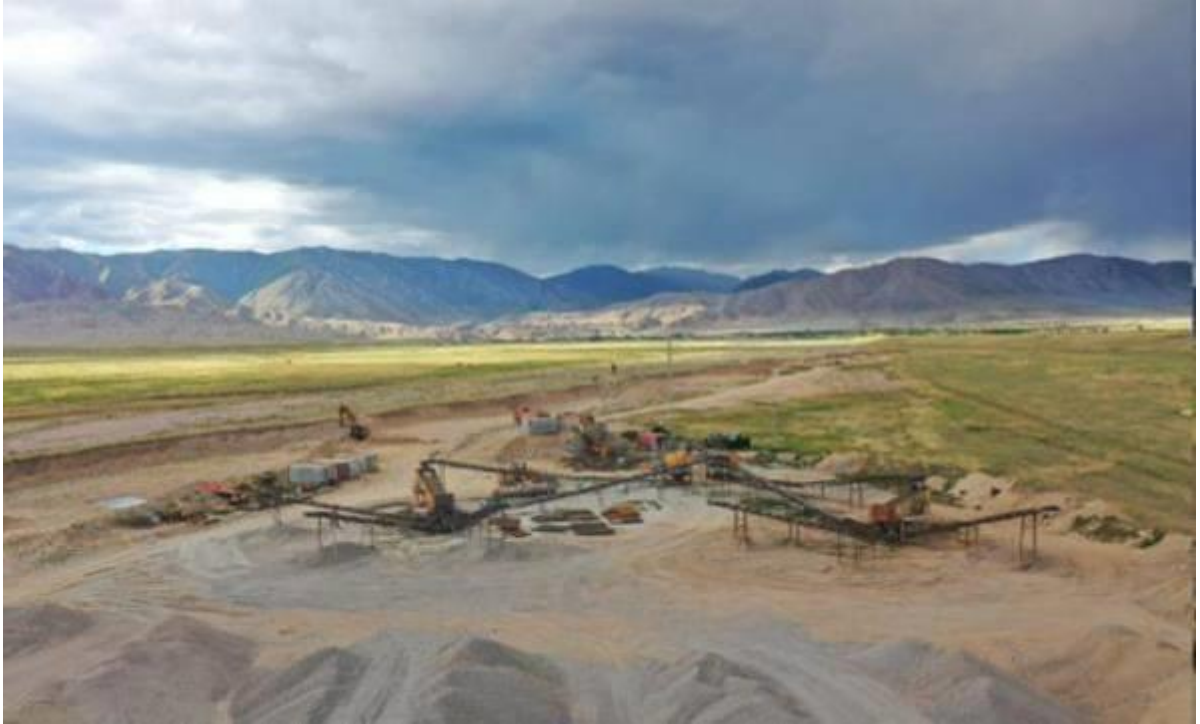
Figure 22 Crusher at the production site (km 148+630).
